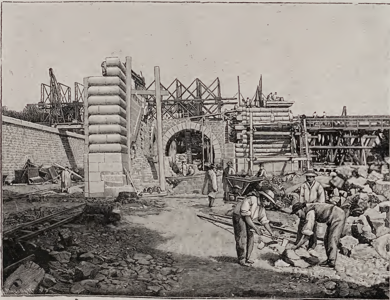
DÉVIATION DES LIGNES DE TRAMWAYS. — La pile du pont Alexandre, montrant à gauche, le nouveau passage du tramway.
